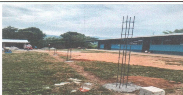
Foto6: Esta fotografía representa la fundición de la columna de la aplicación del corredor de la escuela
