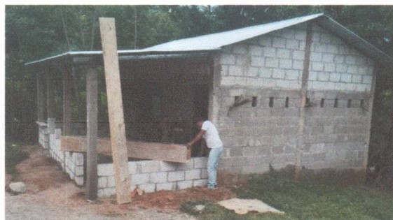
2: La cocina escolar le pusieron la estructura metálica y el corredor
