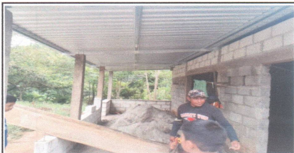
Foto5: Esta fotografía representa la fundición del piso del corredor
